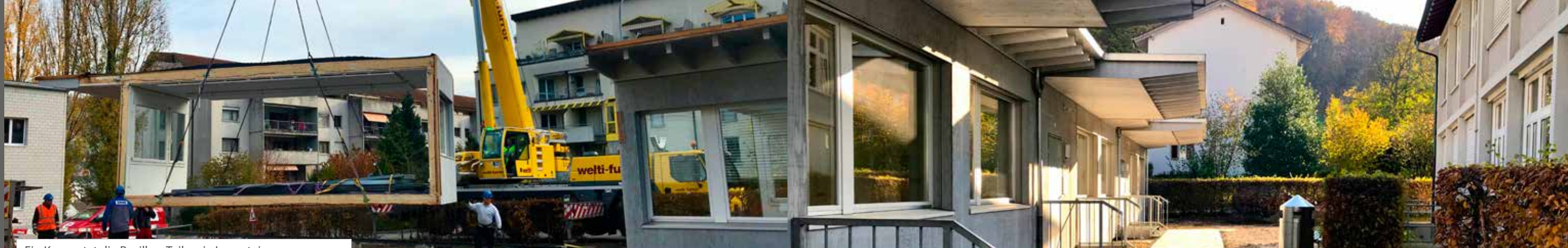
Ein Kran setzt die Pavillon-Teile wie Legosteine zusammen
